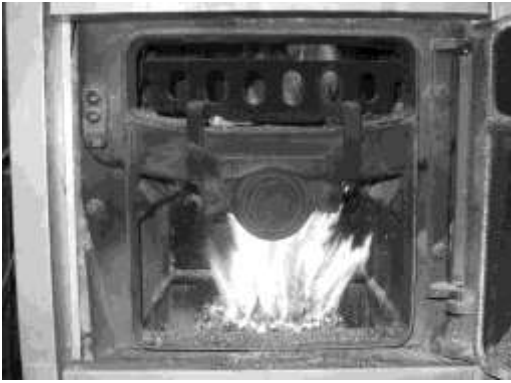
Obr. č. 22 Optimální tvar plamene
