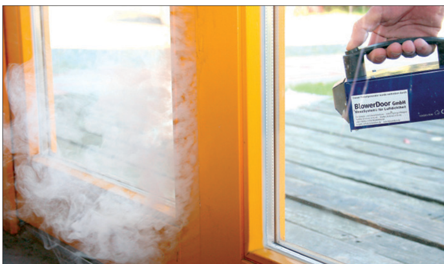
Určování netěsností mlhovým generátorem
